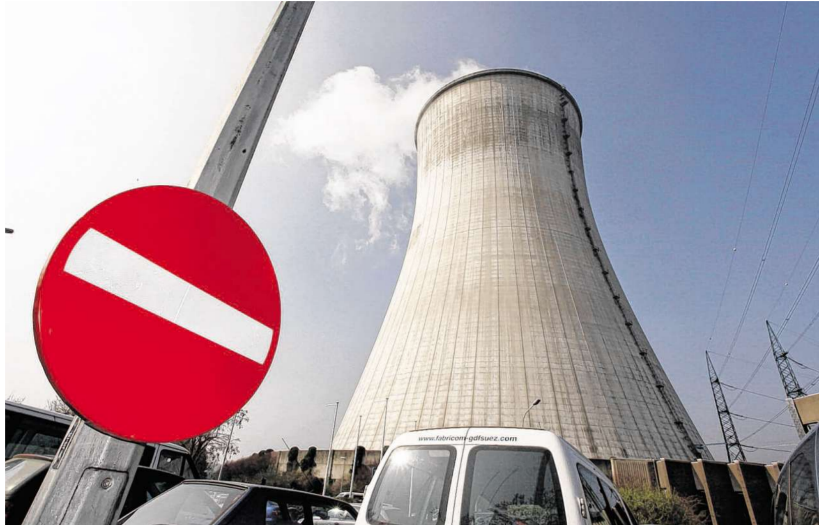
Das Atomkraftwerk Tihange in Belgien, nur 60 Kilometer von Aachen entfernt: Atomkraft-Gegner kritisieren die veraltete Technik und die mangelhafte Informationspolitik der Kraftwerksbetreiber.
